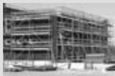
Échafaudage de construction
