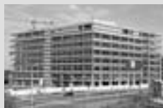
Échafaudage de façade
