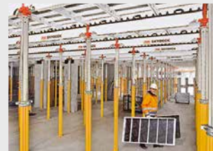
Coffrages de dalles
