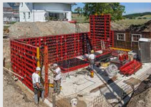
Coffrages de voiles
