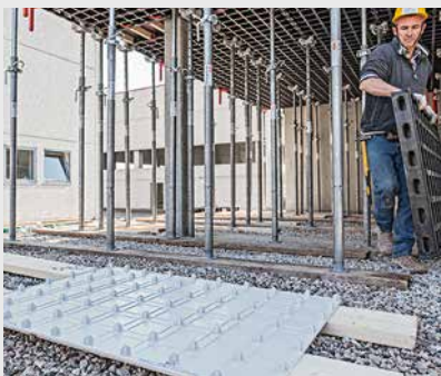
3. Fourniture de la nouvelle peau coffrante
