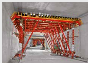
Coffrages de tunnels
