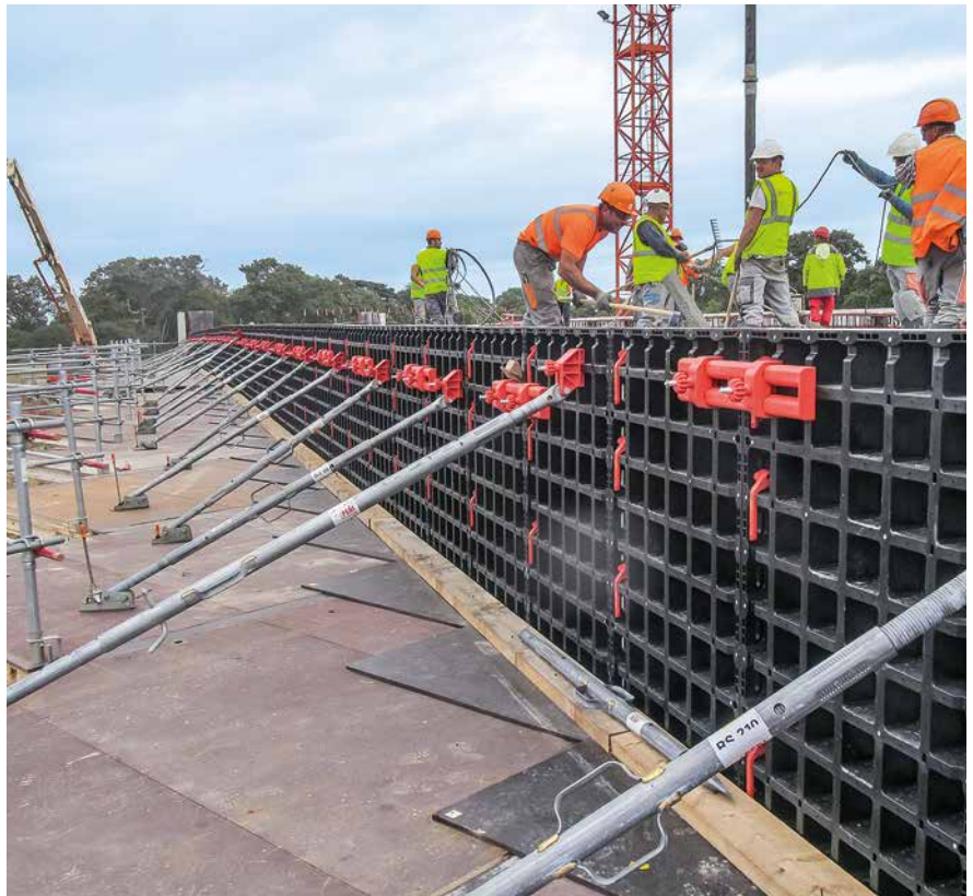
Avec ses panneaux de petites dimensions et sa simplicité de manipulation, DUO est destiné au coffrage de fondations.
