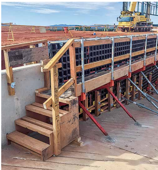
L'utilisation du système DUO a permis d'améliorer considérablement l'efficacité sur le chantier.
