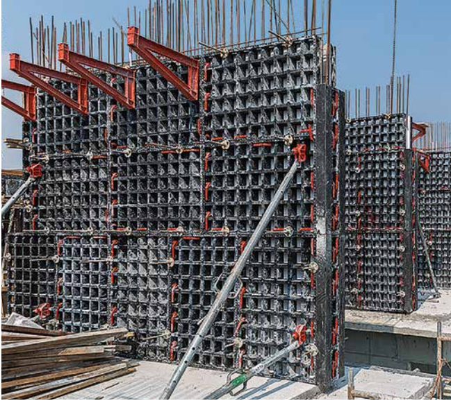
Première utilisation réussie du coffrage léger universel pour la réalisation de sections de voiles.
