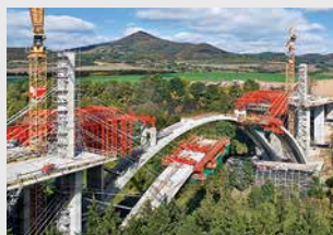
Coffrages de ponts
