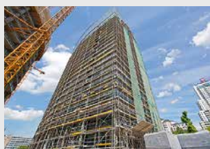
Echafaudages de façades
