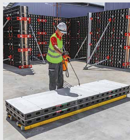
Le pulvérisateur d'agent de décoffrage facilite l'application du produit PERI Plasto Clean.
