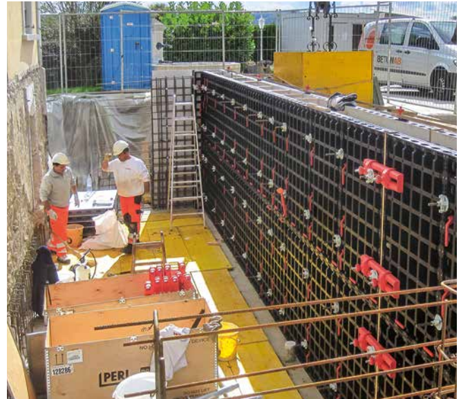
Rénovation et ajout sans grue : aucun problème avec le système DUO.
