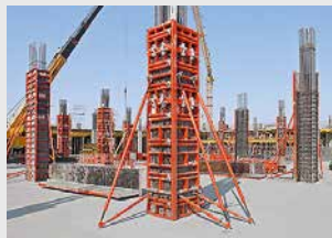
Coffrages de poteaux
