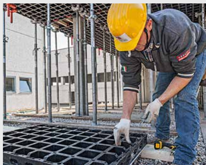
4. Vissage de la nouvelle peau coffrante
